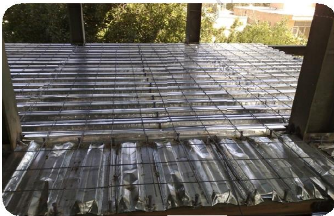
شکل ۱۷: اجرای ورق گالوانیزه و میلگردهای حرارتی سقف عرشه فولادی
